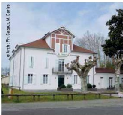
Labouheyre : un ancien hôtel rénové en logements locatifs (Arch : Ph. Cazaux, M. Daries)
